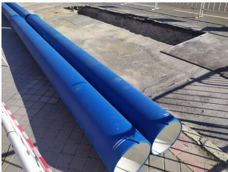
Algunas de las nuevas tuberías.
