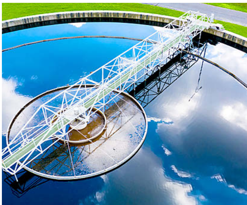
Planta de tratamiento de aguas residuales. iStock
