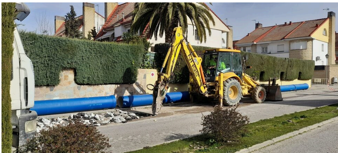
Obras de renovación.
